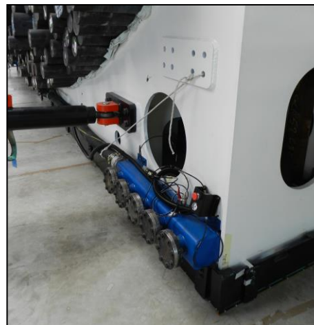
Collegamento flangiato per i tubi flessibili di mandata dell'aria dai compressori
