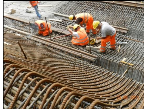
Realizzazione dell'armatura di una sella
