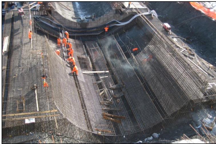
Completamento della sella per il montaggio e la traslazione della TBM
