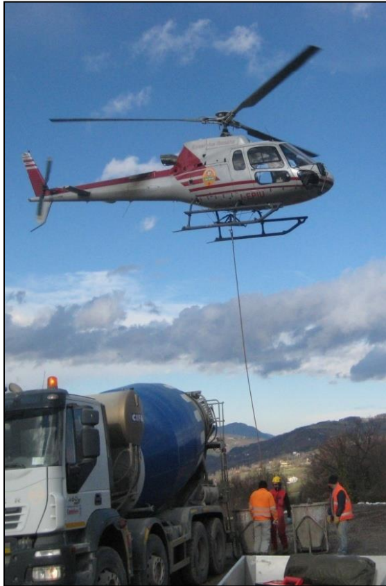
Realizzazione di fondazioni con eli-getto
