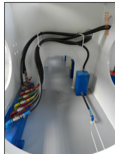
Sistema pneumatico di distribuzione e controllo della pressione dell'aria in entrata nei cuscini Aerogo
