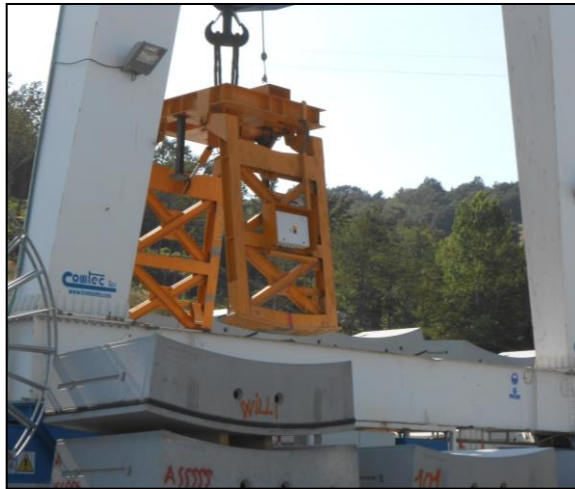
Movimentazione e trasporto nel piazzale esterno e approvvigionamento TBM
